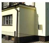
Otvor s rozvaděčem po montáži dvířek
