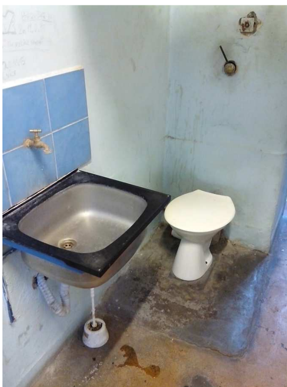
Obrázek 3 – pohled na stávající sociální zařízení cel
