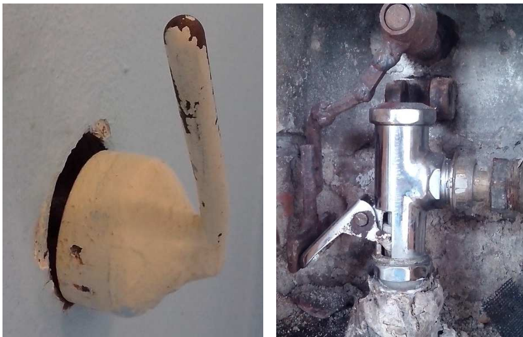
Obrázek 2 - současný splachovací mechanismus
