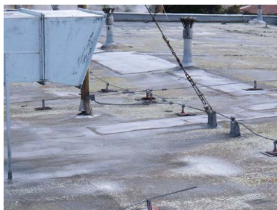
Obr. 20: detail kotvení spalínovodu (komínu)
