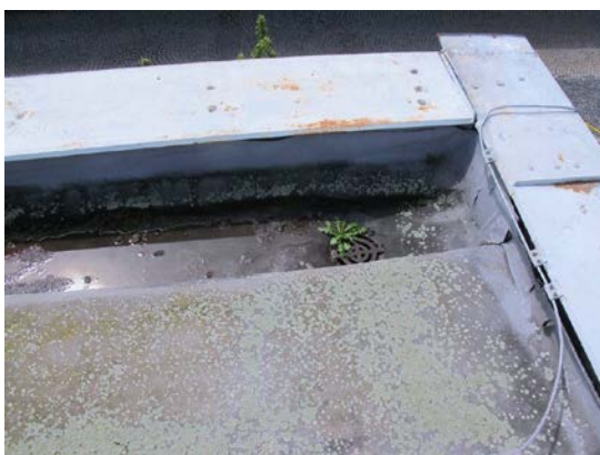
Obr. 17: detail střešní litinové vpusti
