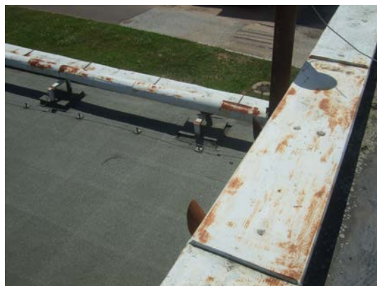
Obr. 22: střecha snížené části plynové kotelny
