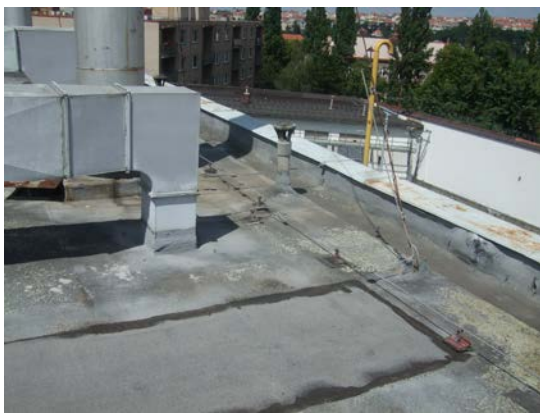
Obr. 13: pohled na střechu plynové kotelny
