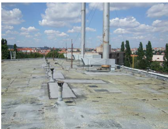
Obr. 9: pohled na střechu plynové kotelny
