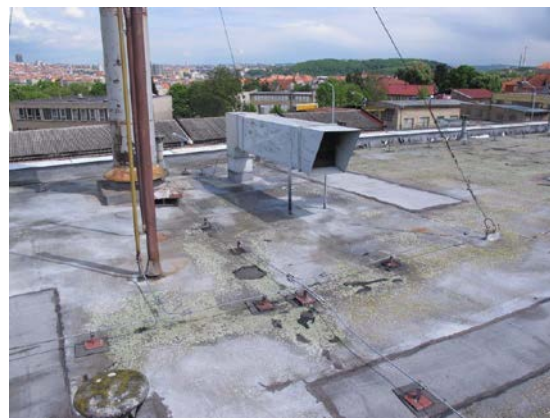
Obr. 12: pohled na střechu plynové kotelny
