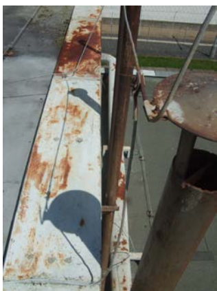
Obr. 6: potrubí nad sníženou střechou
