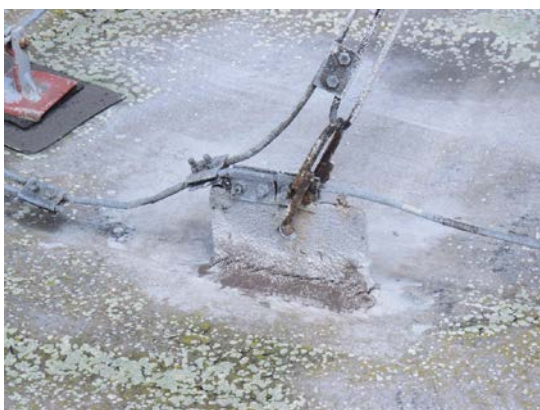
Obr. 19: detail kotvení spalínovodu (komínu)
