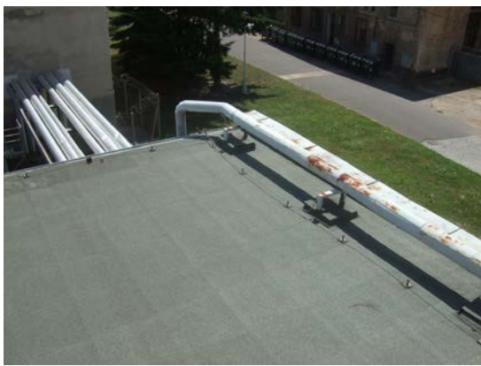
Obr. 21: střecha snížené části plynové kotelny
