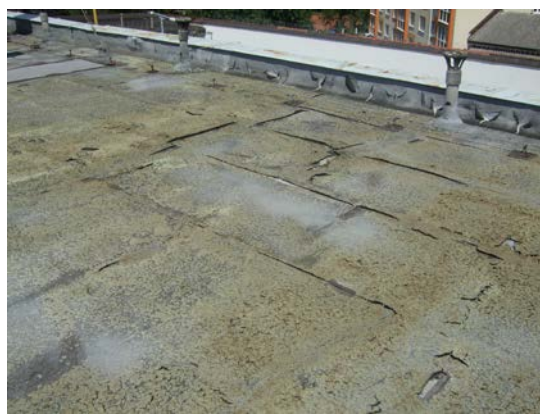
Obr. 16: pohled na střechu plynové kotelny
