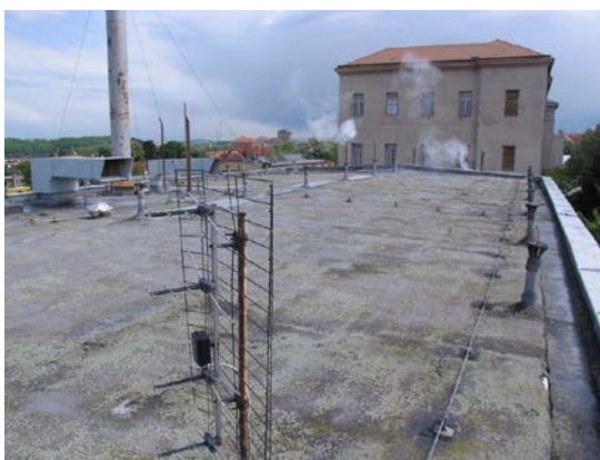
Obr. 15: pohled na střechu plynové kotelny
