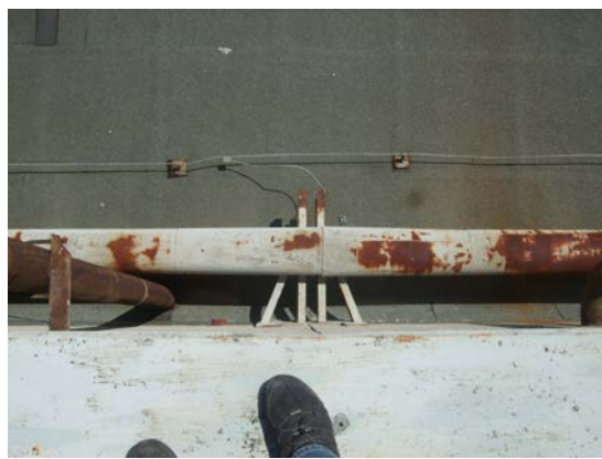
Obr. 6: ukotvení parovodu nad sníženou střechou
