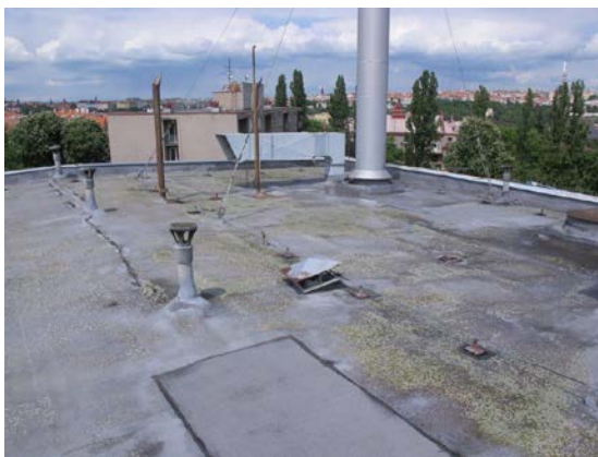
Obr. 11: pohled na střechu plynové kotelny
