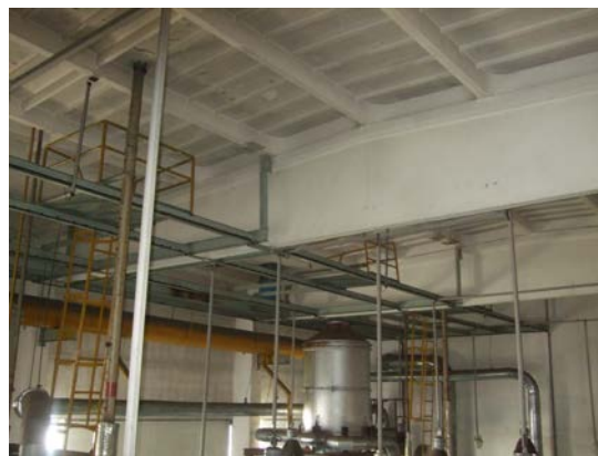
Obr. 8: strop plynové kotelny
