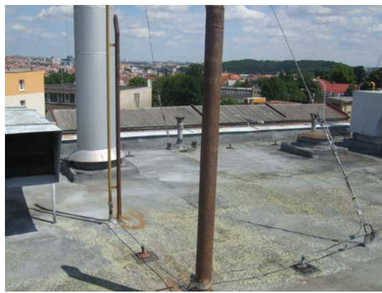
Obr. 14: pohled na střechu plynové kotelny
