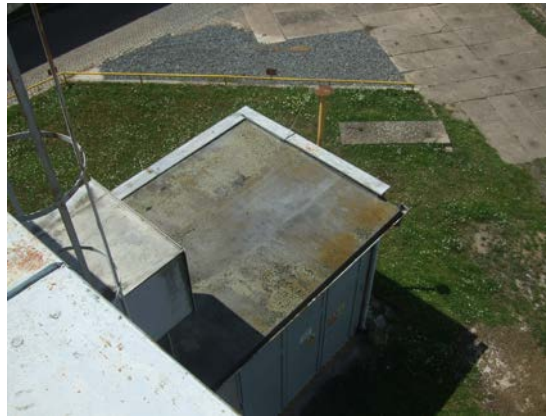
Obr. 6: střecha snížené části – regulační
