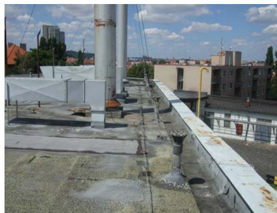
Obr. 10: pohled na střechu plynové kotelny
