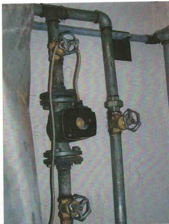
Elektrické bojlery a oběhové čerpadlo pro TUV - budova B
