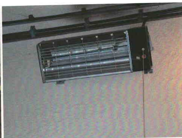
Dílny a vodárna - elektro-akumulační kamna a el. přímotop pro temperaci
