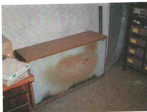
Dílny a vodárna - elektro-akumulační kamna a el. přímotop pro temperaci
