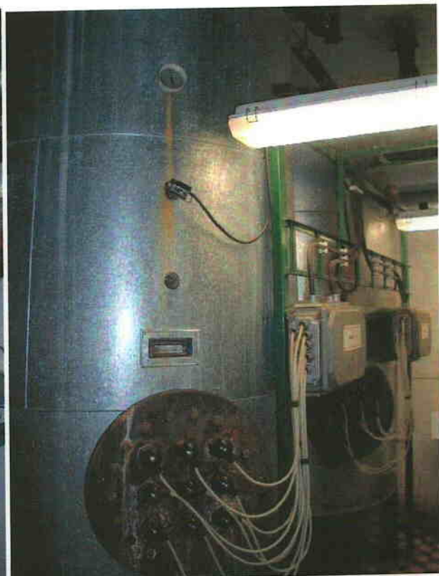
Kotelna - budova A - boiler TUV napojen na solární kolektory a elektrické boilery TUV
