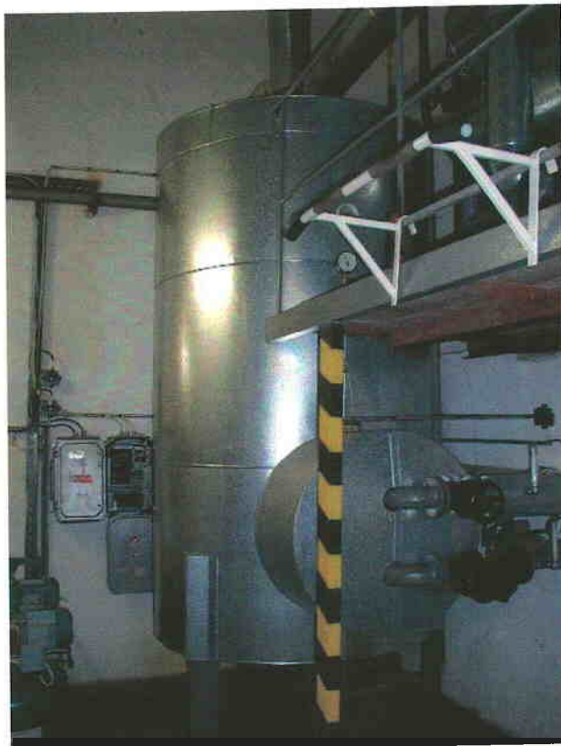
Kotelna - budova A - boiler TUV napojen na solární kolektory a elektrické boilery TUV
