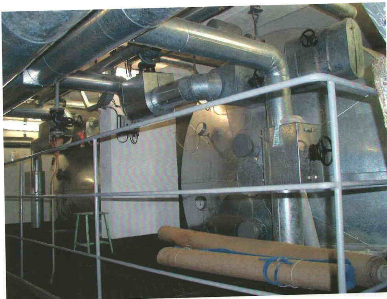
Akumulační nádrže -kotelna v objektu A
