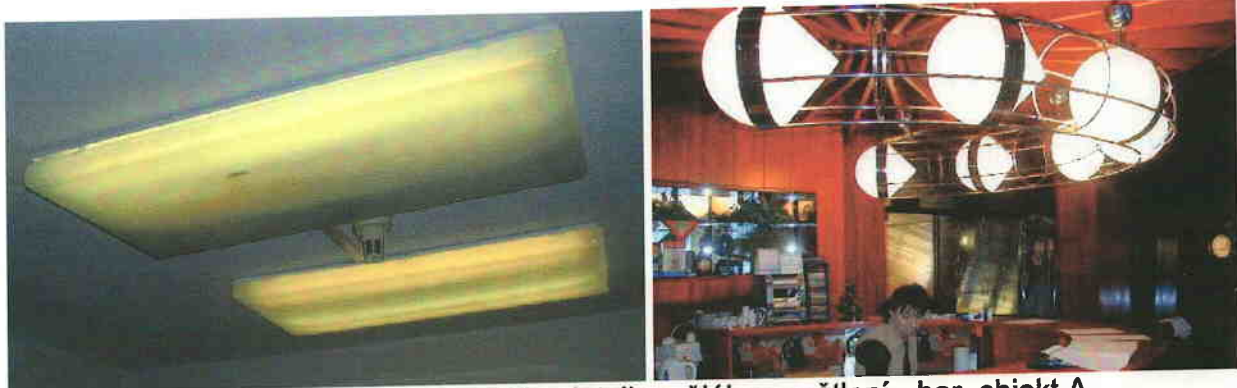
Vyteklý kondenzátorový olej - kancelář a detail umělého osvětlení - bar, objekt A
