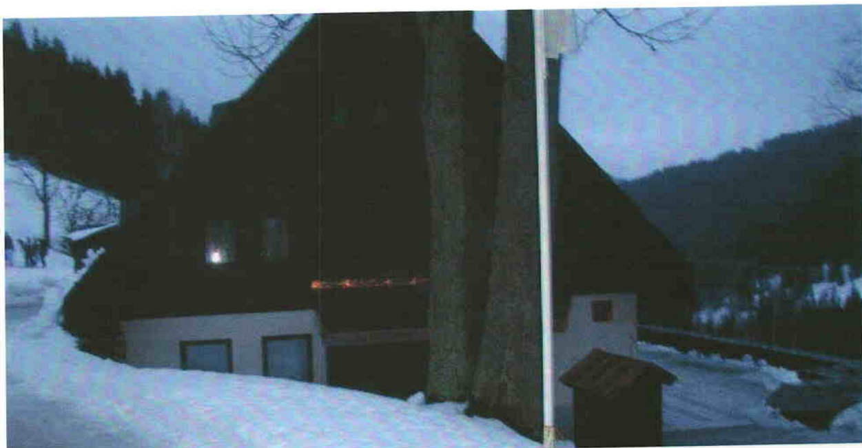
Objekt B - západní fasáda
