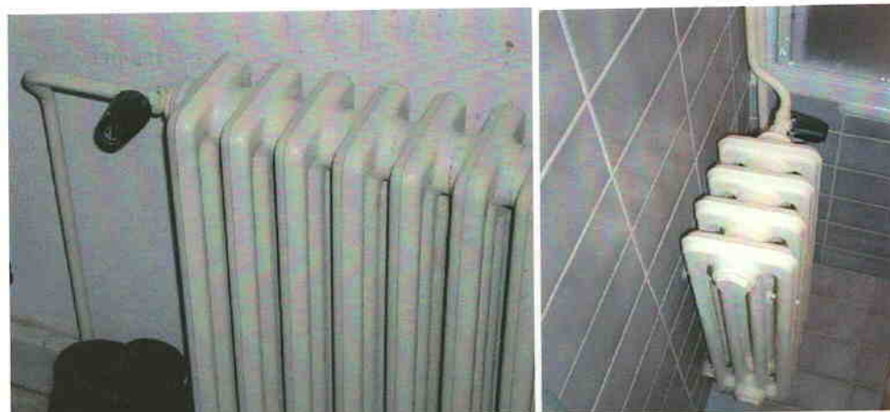
Otopná tělesa s s ručními regulačními ventily
