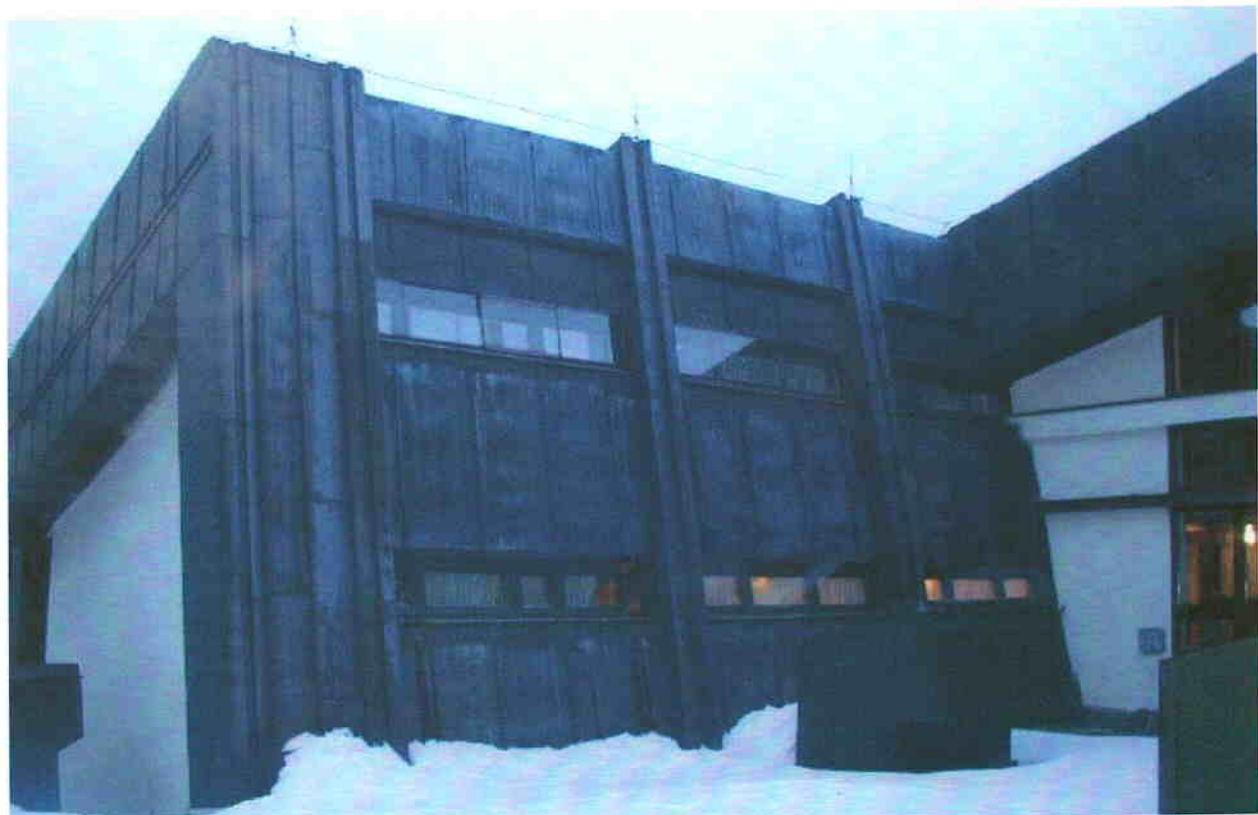
Objekt A - detail fasády, pohled ze S-V
