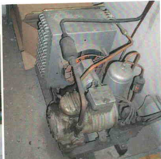
Chladicí agregát - objekt A
