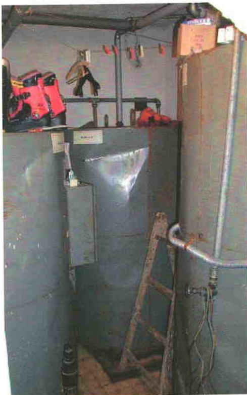
Elektrické bojlery a oběhové čerpadlo pro TUV - budova B
