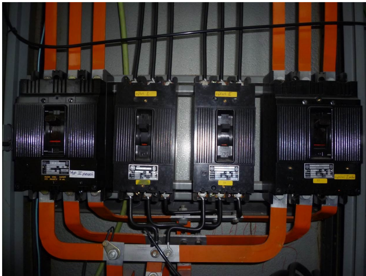
Obrázek 10 – Rozvaděč výtahu
