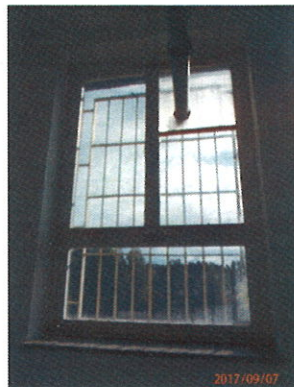
Foto stávajícího okna s ventilačním prostupem v místnosti č. 324:
