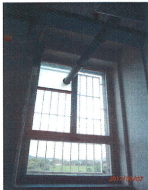
Foto stávajícího okna s ventilačním prostupem v místnosti č. 317:
