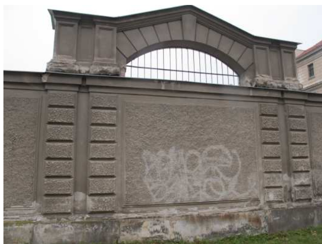
Foto č.12 – Vlivem poškozeného oplechování koruny ohradní zdi jsou lokálně poškozeny povrchové úpravy i ve vyšších úrovních. Pohled z ulice Havlíčkova.
