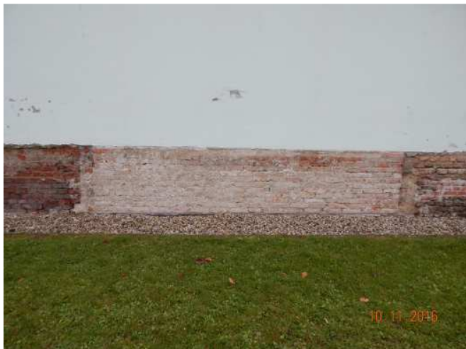
Foto č.13 – v minulosti bylo provedeno zazdění brány s vložením asfaltové izolace. Tato část má vlhkostní problémy pouze v omezené míře.
