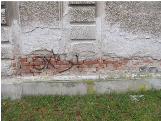
Foto č.9 – vlivem vlhkost a mrazivých cyklů obnažené cihelné zdivo ohradní zdi, kde můžou atmosferické srážky volně zasakovat a dale poškozovat stavebně technický stav zdi.
