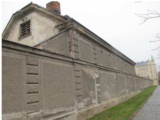
Foto č.10 – pohled na objekt prádelny, který navazuje na západní část ohradní zdi. Špatný stavebně technický stav objektu prádelny ovlivňuje vlhkostní stav ohradní zdi a doporučujeme ho prověřit vlhkostním průzkumem.
