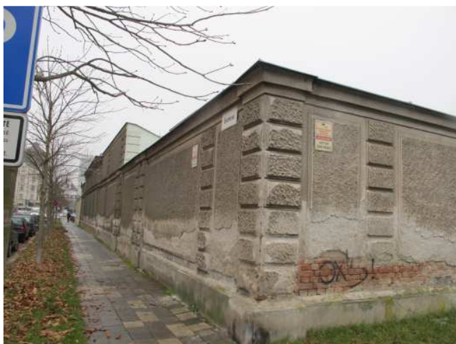
Foto č.7 – severozápadní nároží ohradní zdi s negativními vlhkostními projevy zasahující do úrovně cca 1,5 m.
