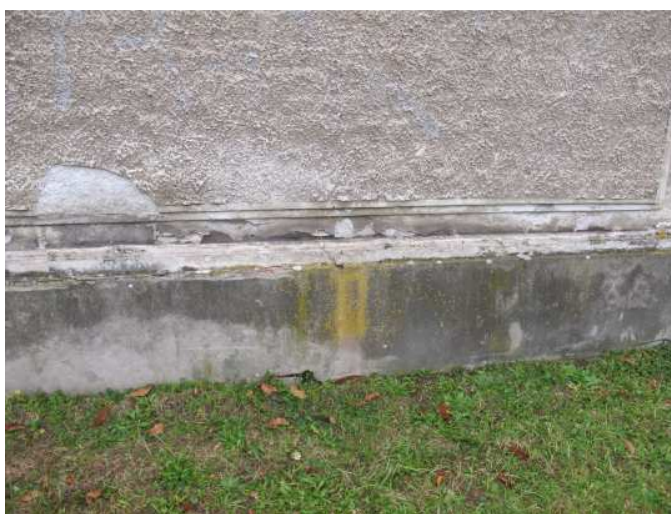
Foto č.11 – vlivem vlhkosti a nevhodné orientace ohradní zdi ke světovým stranám jsou stávající povrchové úpravy napadeny biotickým napadením (mechy, lišejníky, aj.)
