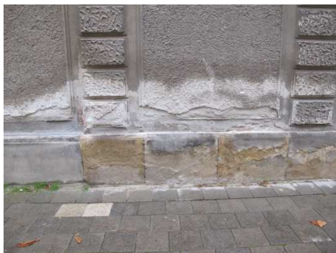
Foto č.8 – viditelná úroveň odpařovací zóny vlhkého zdiva. Vlivem vlhkosti a mrazivých cyklů je poškozený také pískovcový sokl fasády.
