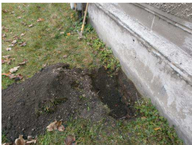
Foto č.15 – pohled na provedenou kopanou sondu z ulice Havlíčkova pro ověření stavebně technického provedení ohradní zdi pod úrovní terénu.
