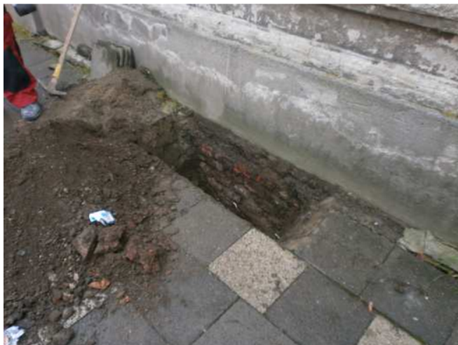
Foto č.14 – pohled na provedenou kopanou sondu z ulice Švermova pro ověření stavebně technického provedení ohradní zdi pod úrovní terénu.
