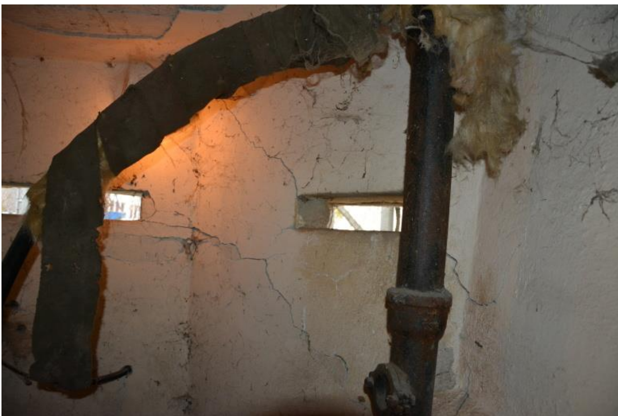
Foto 22.: Přímý náhled na velké trhliny a narušení obvodového zdiva suterénu
