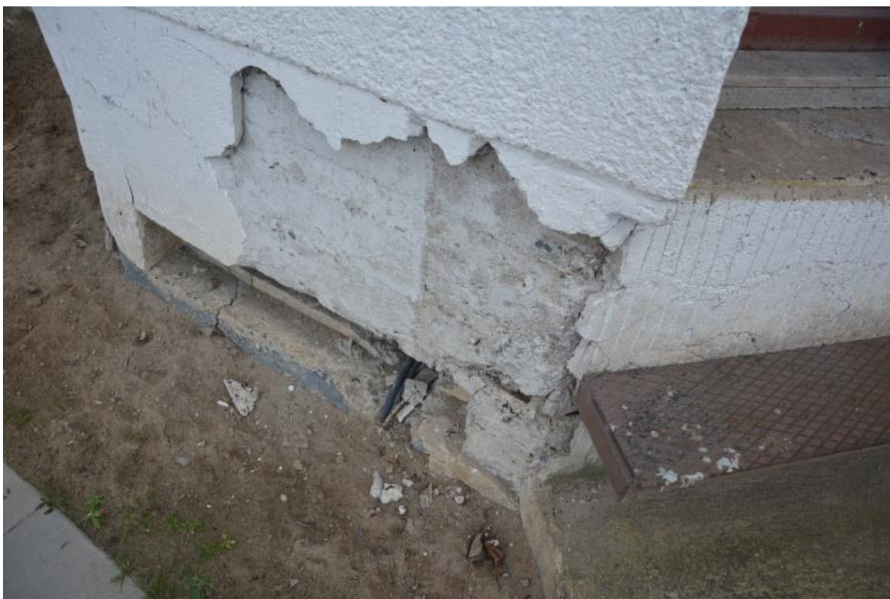
Foto 8.: Narušení omítky obvodového zdiva a trhliny v konstrukci
