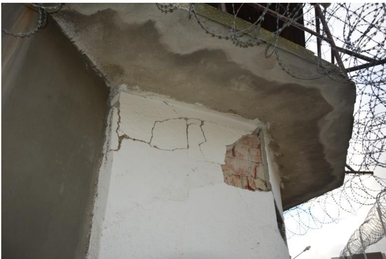
Foto 4.: Další trhlina v obvodové stěně a silně narušená vnější omítka
