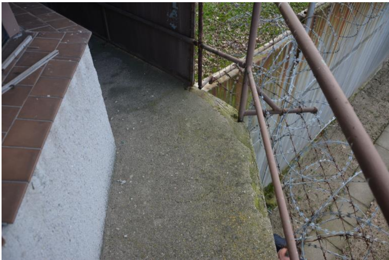
Foto 11.: Pohled na erodovaný povrch podlahy venkovního ochozu (jiné místo)
