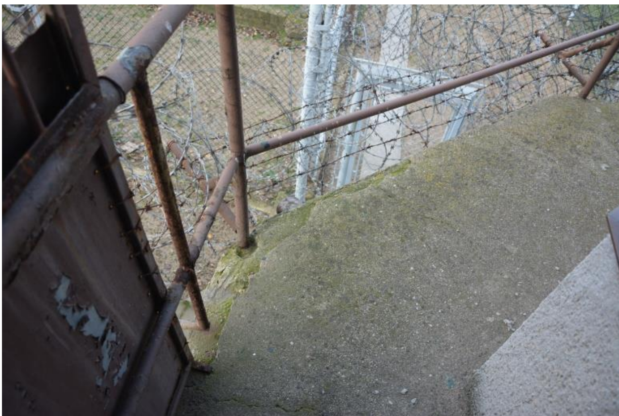
Foto 10.: Pohled na erodovaný povrch podlahy venkovního ochozu
