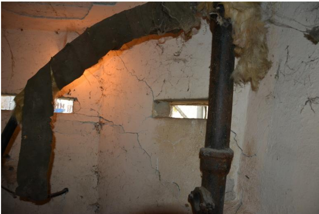
Foto 20.: Suterénní betonové zdivo, rovně naružené trhlinami
