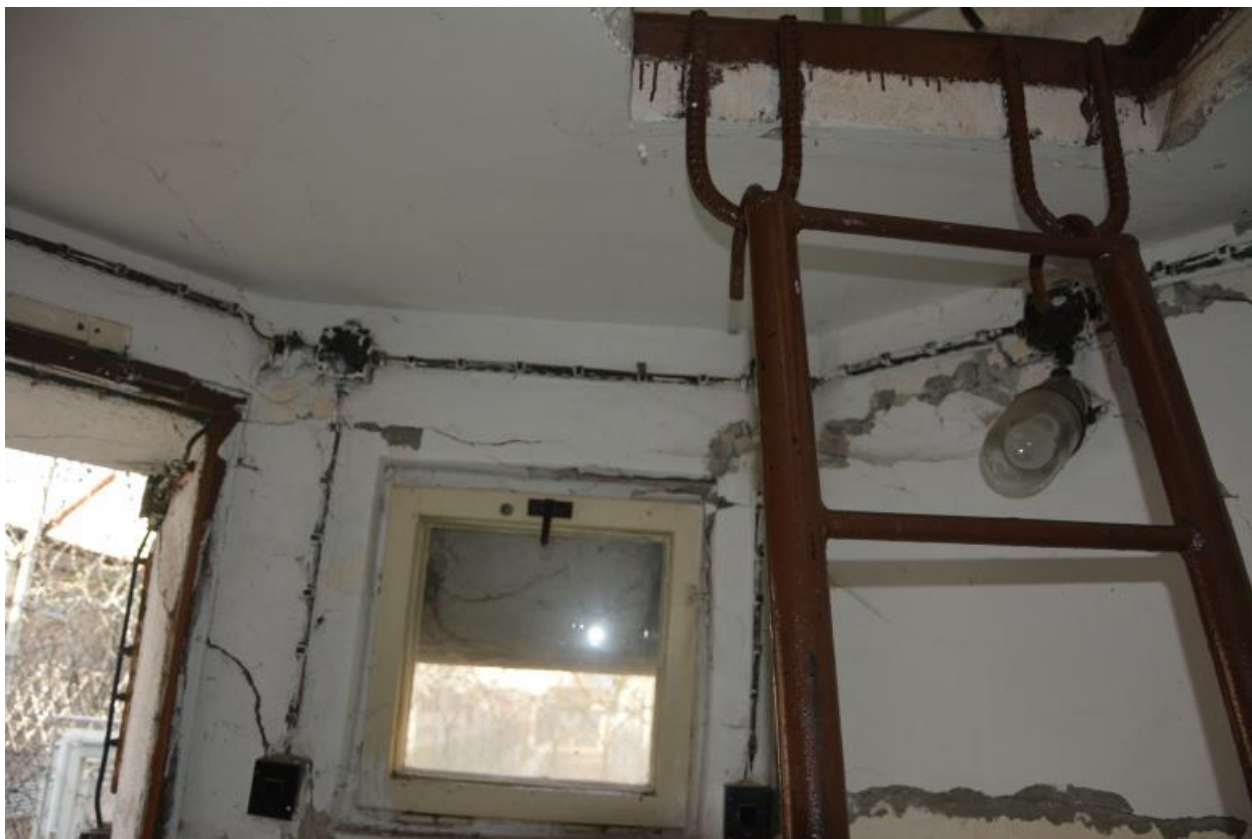
Foto 17.: Souvislá trhлина od nadpraží vstupních dveří až k zikmému lomu obvodové stěny (1.N.P.)
