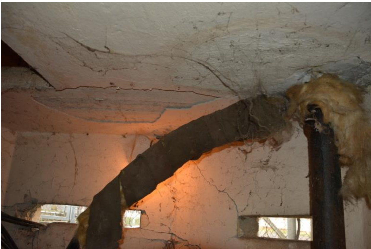
Foto 21.: Stropní konstrukce nad suterénem, rovněž s lokálními trhlinami
