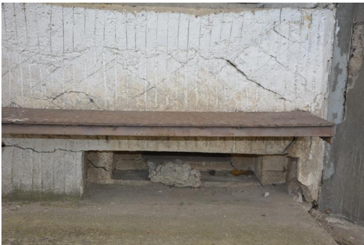
Foto 9.: Další lokální naruzení u otvoru pod vstupními dveřmi
