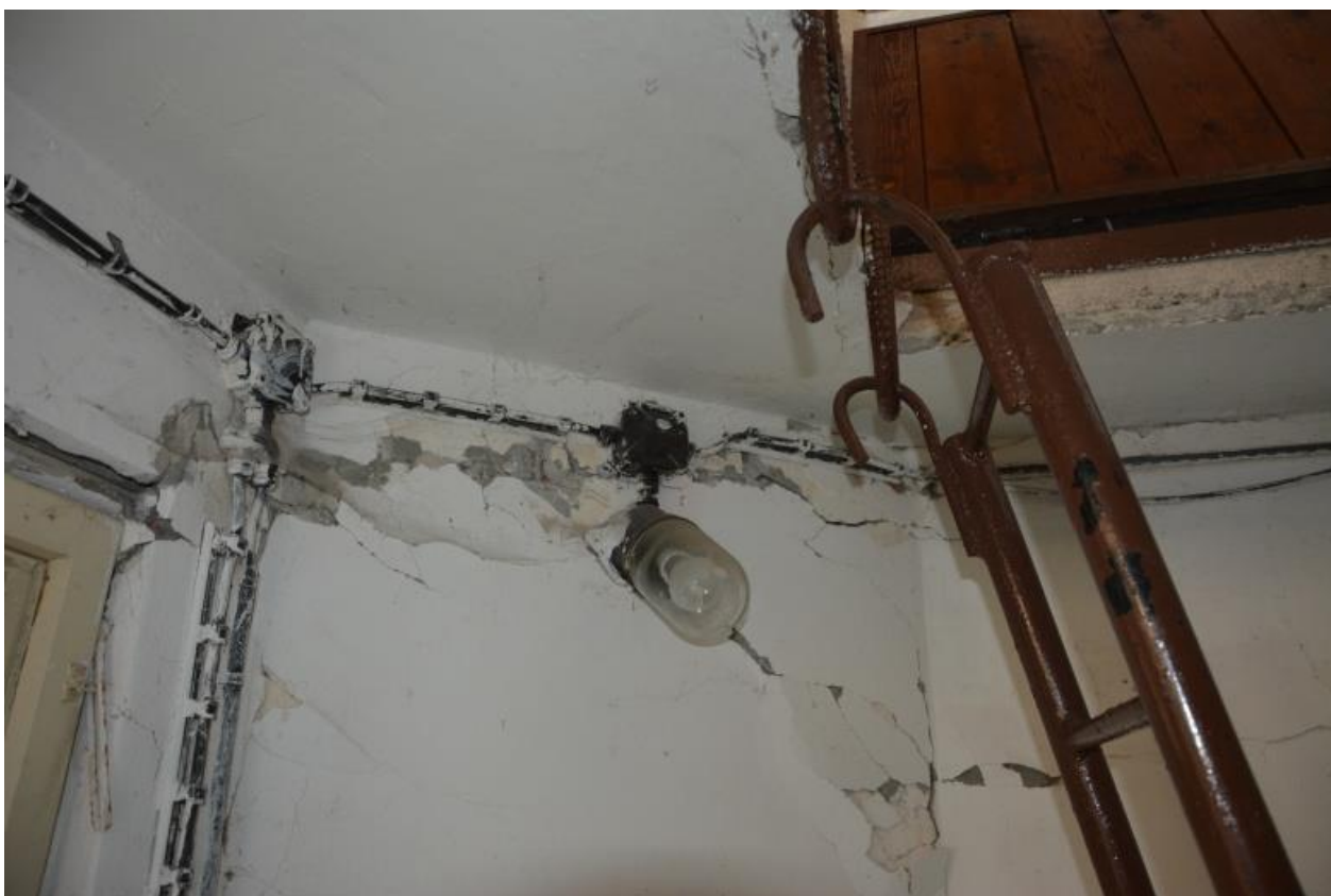
Foto 18.: Svislé pokračování této trhliny
