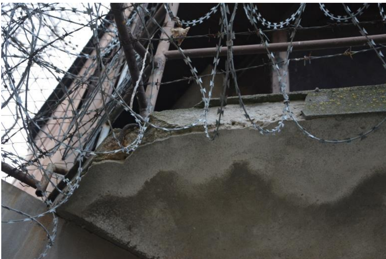
Foto 2.: Narušený okraj ocelobetonové krakovací desky v jižní části
