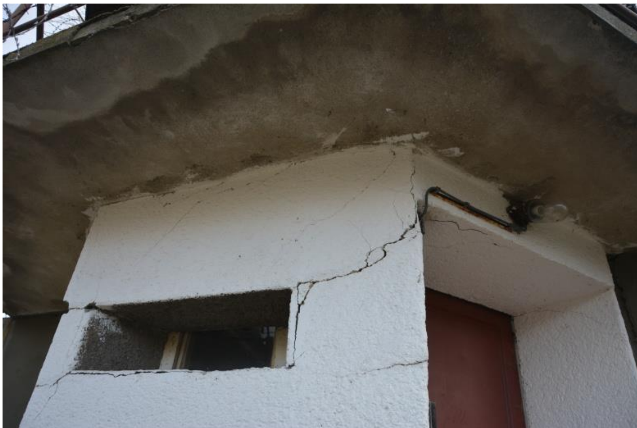
Foto 3.: Výrazná trhlina od parapetu okenního otvoru k nadpraží otvoru dveří (vstup)
