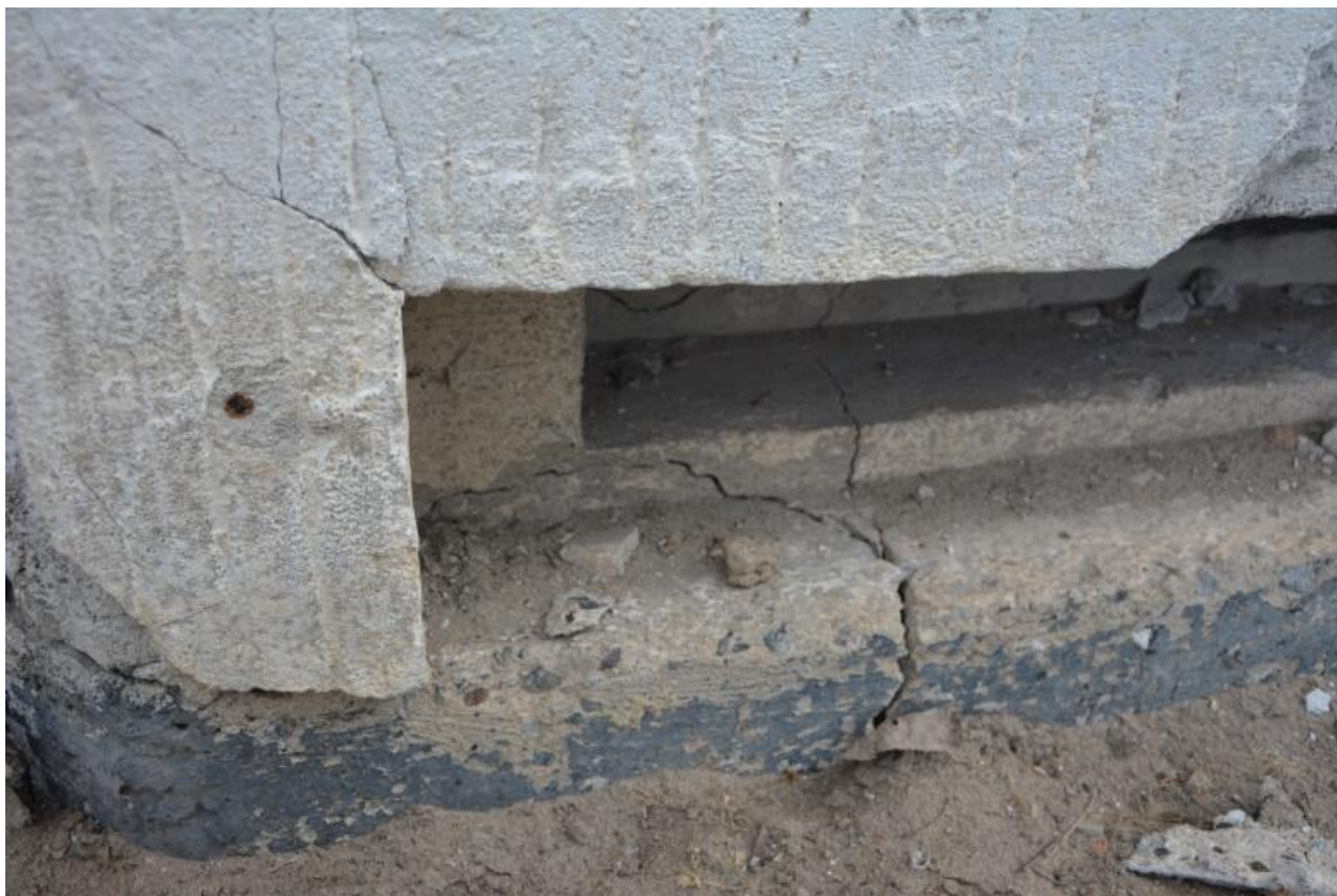
Foto 7.: Bližší náhled na naruzené betonové suterénní zdivo
