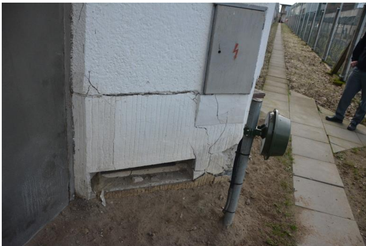
Foto 6.: Narušení nad terénem, především u meziokenních pilířů
