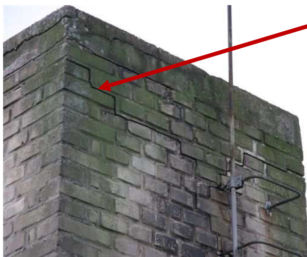
Stav konstrukce z ledna 2012
