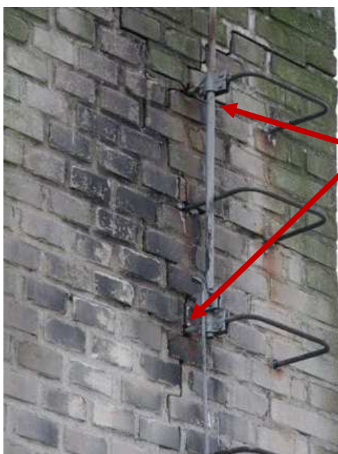
Trhliny v místech uchycení stoupacích skob
