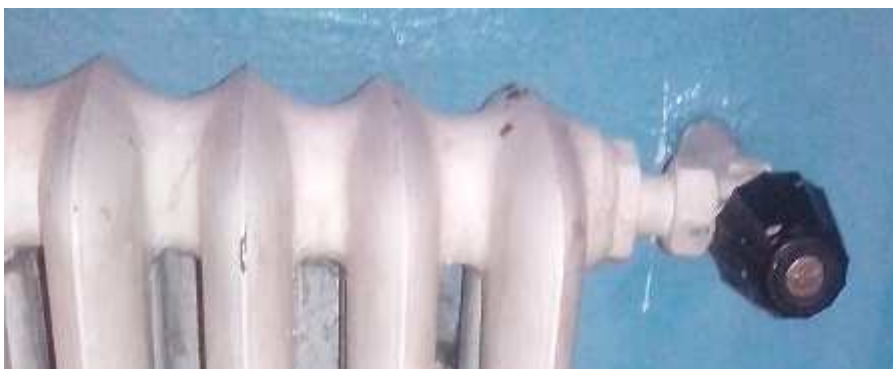
Obrázek 6 - těleso na konci traktu 1.B, kde bude instalována termostatická hlavice
