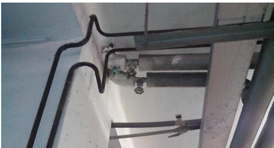
Obrázek 3 – současný stav vedení ústředního topení
